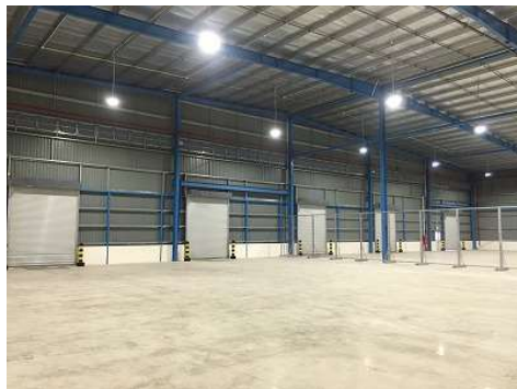
【庫内ドック側】
